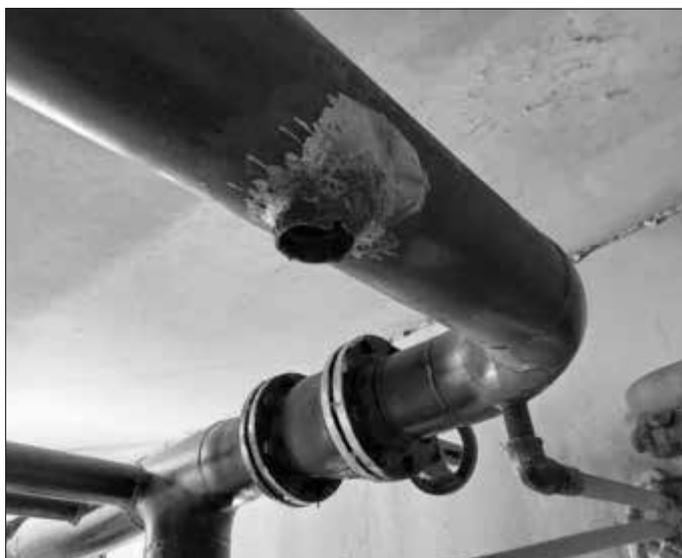
Rohrbruch in einem Verteilerschacht
