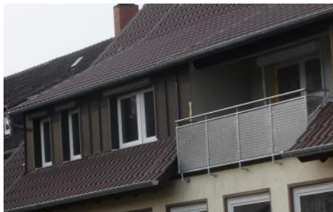
Die Pfarrwohnung, jetzt mit Balkon
