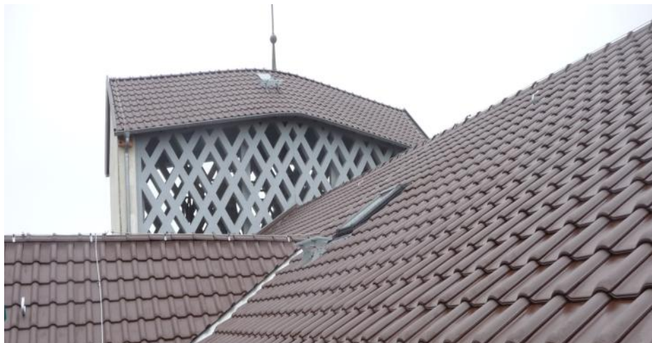
Das neu gedeckte Dach des Gemeindezentrums der Paulusgemeinde
