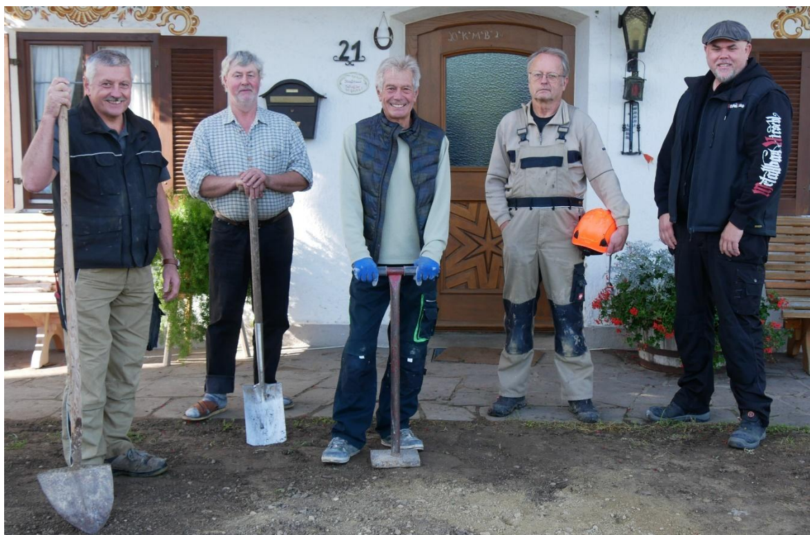
Werner Breuherr und Sepp Hatzl beim Hochziehen des Aushubs. Im Schacht Marinus Niggel.
