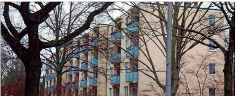
Bebauung Marienfelder Chaussee in Buckow
