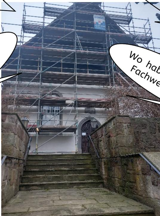
Keine Panik, das Fachwerk ist noch da und wird auch wieder in alter Frische erstrahlen! Es gab da nur ein kleines Problem: Es stellte sich heraus, dass bei einigen Gefachen der Unterbau abgängig war. Das hatte zur Folge, dass diese Gefache mit Lehmsteinen allesamt neu aufgebaut werden mussten. Die wiederum kann man erst dann final verputzen, wenn alles komplett getrocknet ist, was in den Wintermonaten nur sehr langsam funktioniert. Somit ist der Giebel momentan
