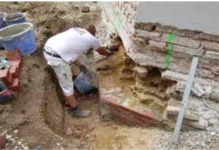
*Handarbeit zum Entfernen des bröckelnden Fundamentes gefragt. Beim Öffnen der Fundamente zeigten sich nämlich größere Schäden als erwartet.*
