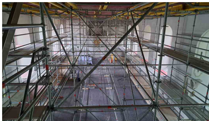
Der Innenraum der Kirche ist völlig eingerüstet
