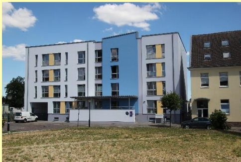
Diakonie in der Baustraße
