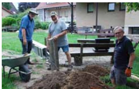
Das Elektroteam bei der Arbeit.
