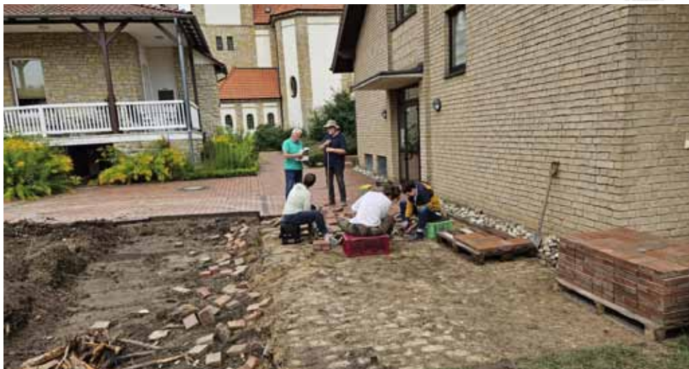
Alte Pflastersteine werden aufgenommen, gereinigt und neu verlegt.
