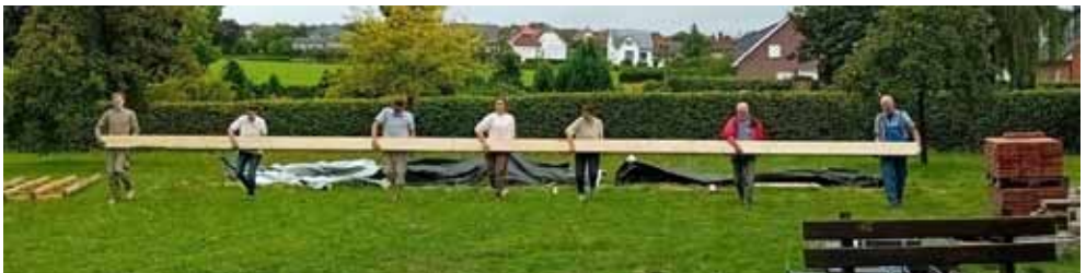
Mächtige Holzbalken werden mit vereinten Kräften zum Pavillon gebracht.
