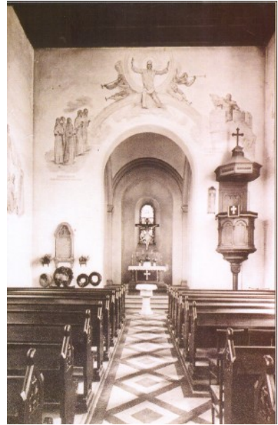
Innenansicht (vor der Renovierung 1971)
